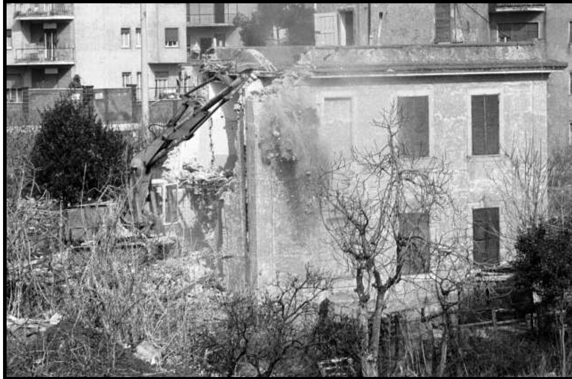
ROMA-ABBATTIMENTO BARACCHE VIA ARCO DI TRAVERTINO ANNO:1979-1980
