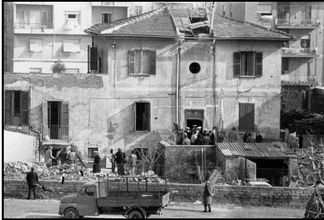
ROMA-ABBATTIMENTO BARACCHE VIA ARCO DI TRAVERTINO ANNO:1979-1980
