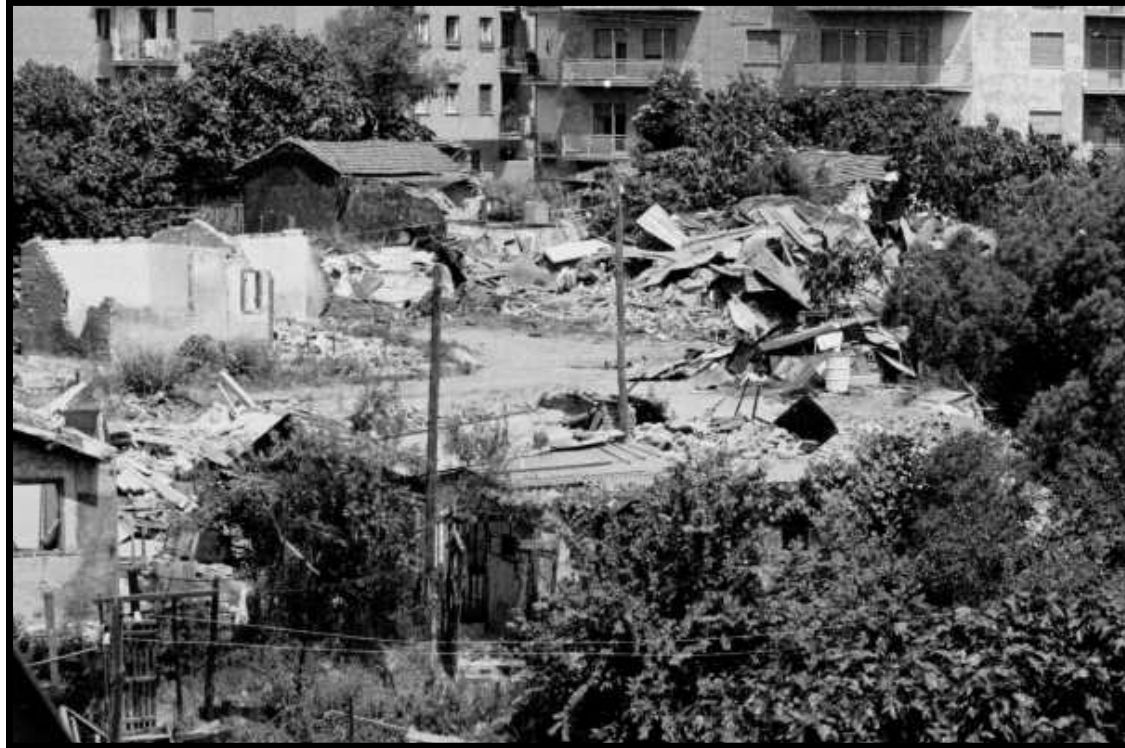
ROMA-ABBATTIMENTO BARACCHE VIA ARCO DI TRAVERTINO ANNO: 1979-1980
