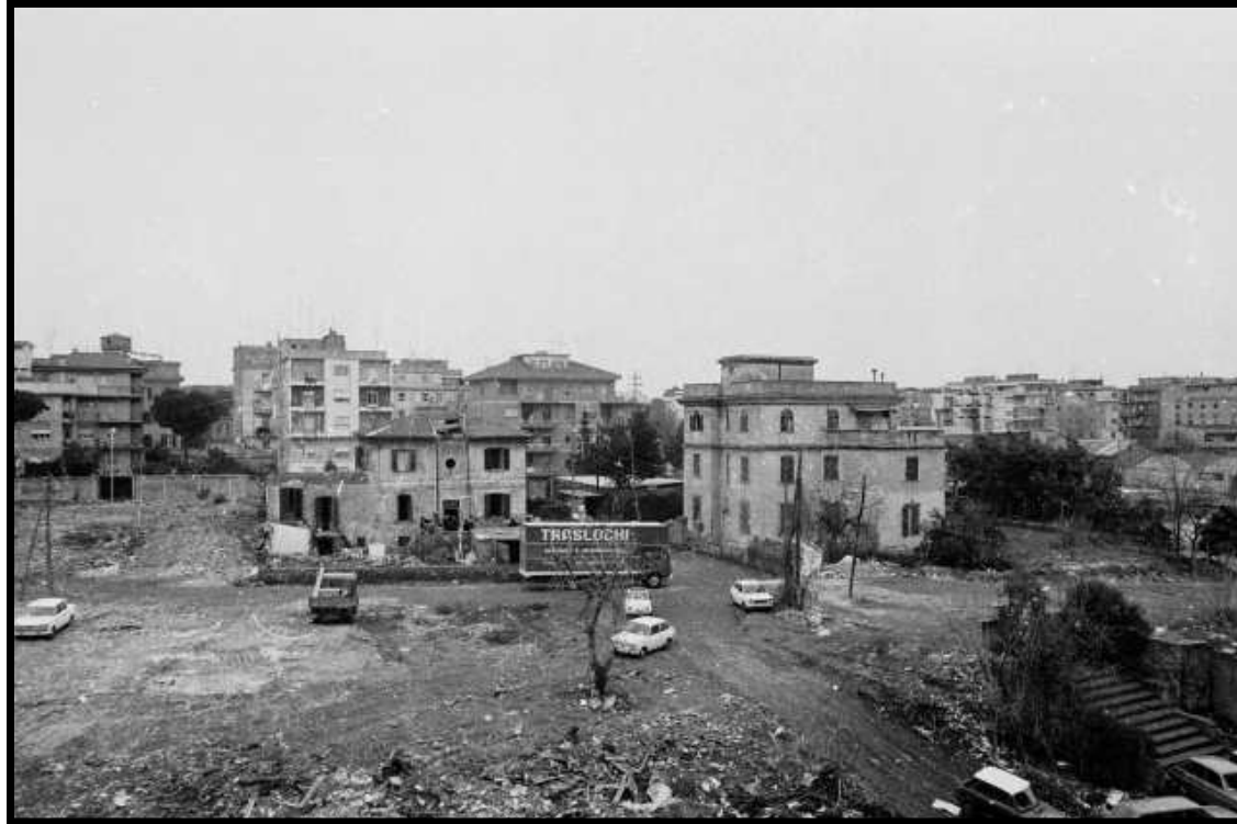
ROMA-ABBATTIMENTO BARACCHE VIA ARCO DI TRAVERTINO ANNO:1979-1980
