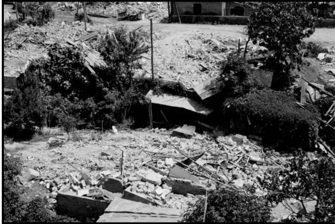
ROMA-ABBATTIMENTO BARACCHE VIA ARCO DI TRAVERTINO ANNO:1979-1980
