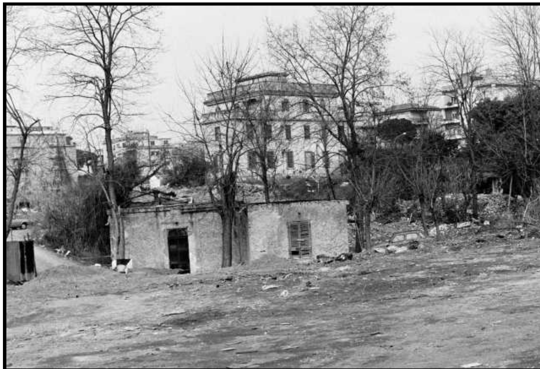
ROMA-ABBATTIMENTO BARACCHE VIA ARCO DI TRAVERTINO ANNO:1979-1980
