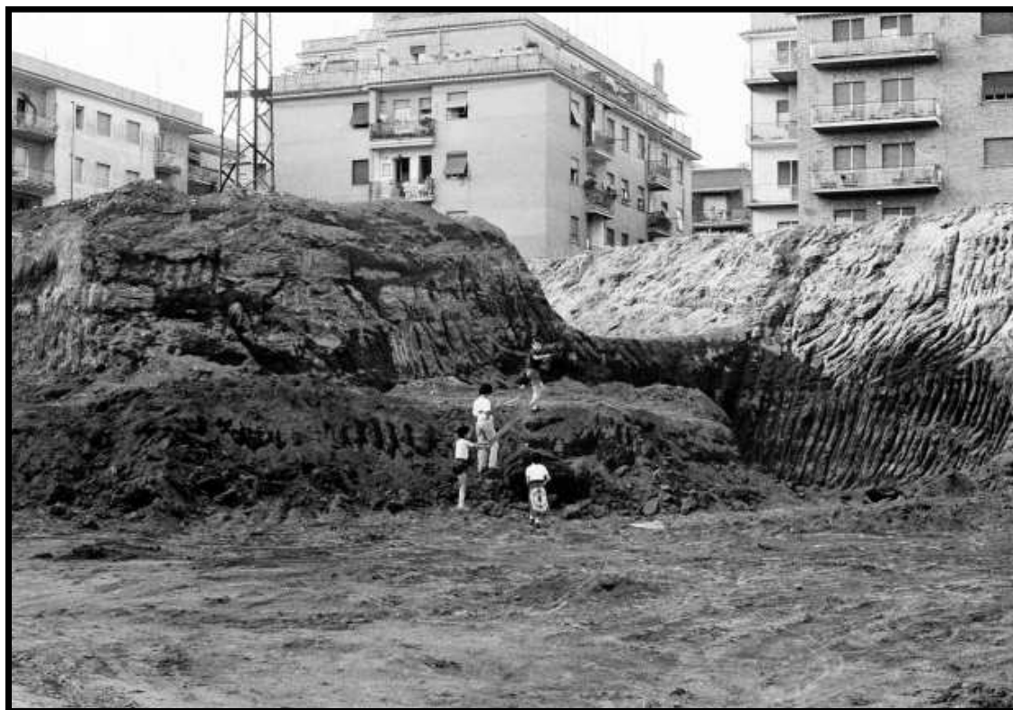
ROMA-ABBATTIMENTO BARACCHE VIA ARCO DI TRAVERTINO ANNO:1979-1980
