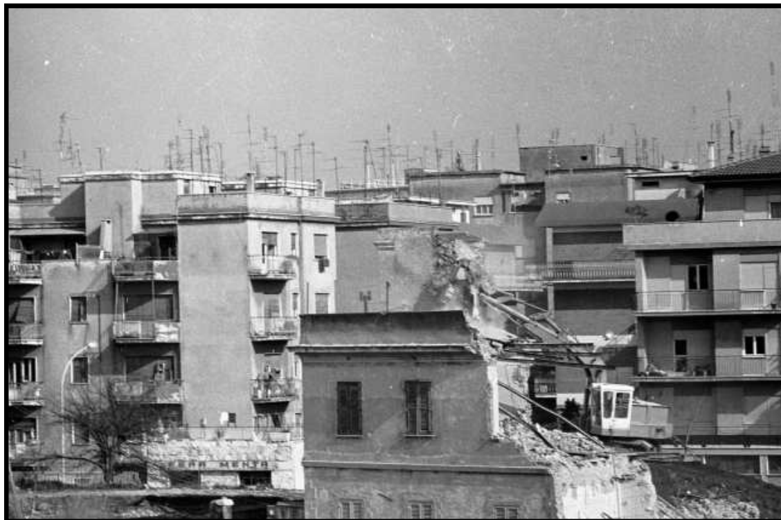
ROMA-ABBATTIMENTO BARACCHE VIA ARCO DI TRAVERTINO ANNO:1979-1980
