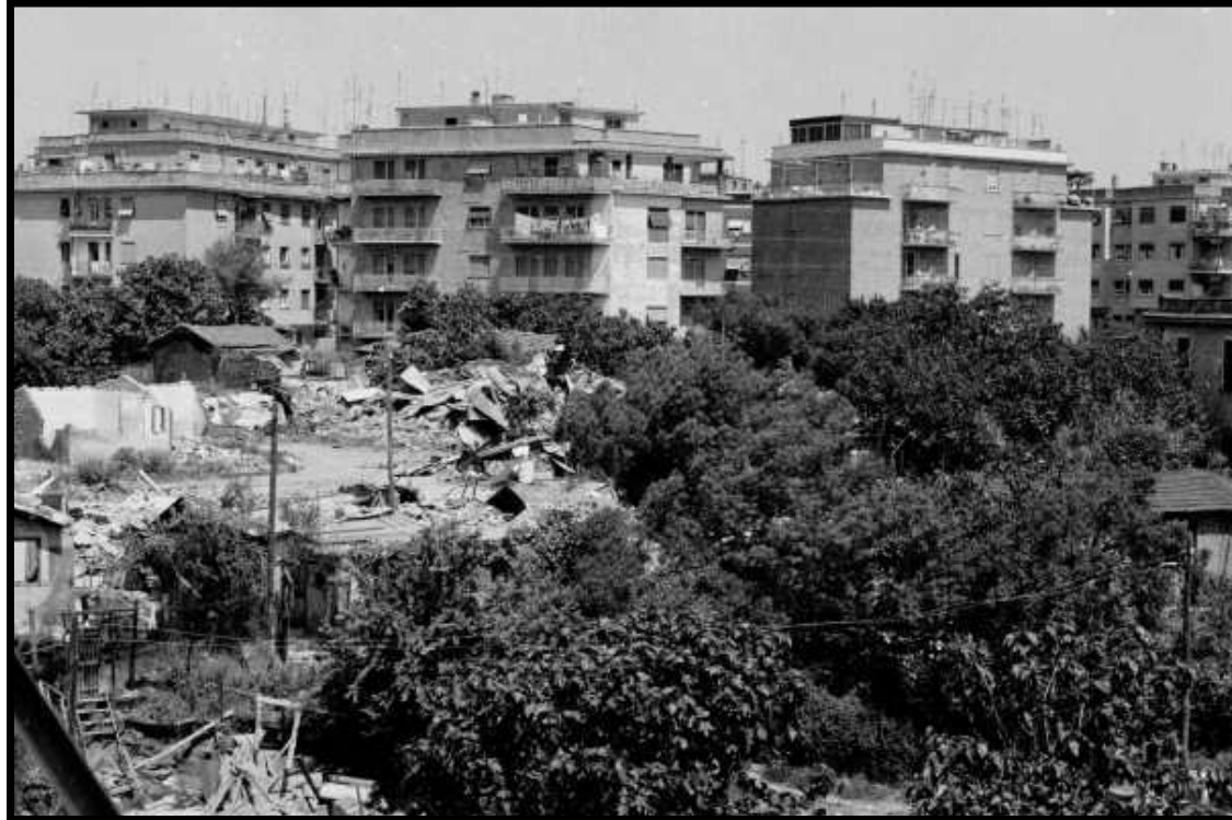
ROMA-ABBATTIMENTO BARACCHE VIA ARCO DI TRAVERTINO ANNO:1979-1980
