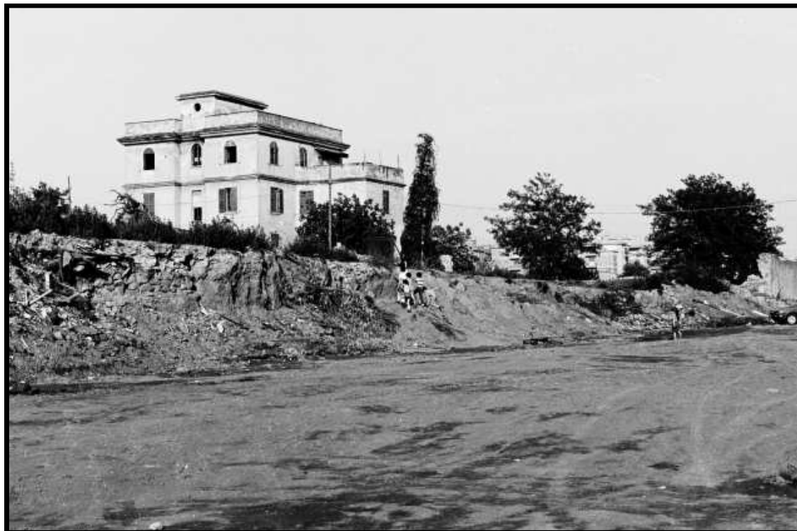
ROMA-ABBATTIMENTO BARACCHE VIA ARCO DI TRAVERTINO ANNO:1979-1980
