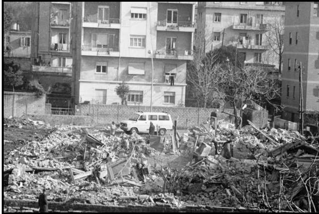
ROMA-ABBATTIMENTO BARACCHE VIA ARCO DI TRAVERTINO ANNO:1979-1980
